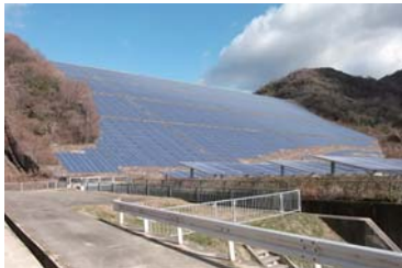
神谷ダム太陽光発電施設完成イメージ
