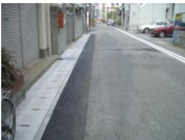
震災で道路の側溝が変形しゴミが詰まり掃除をするのに地域の方が大変苦労されていました。昨年10月要望を受け早速、中部建設事務所に依頼し本年3月末に第一期の側溝が整備されました。予算の関係で引き続き16年度2期延長の工事を要請しています。(H15.H16)
